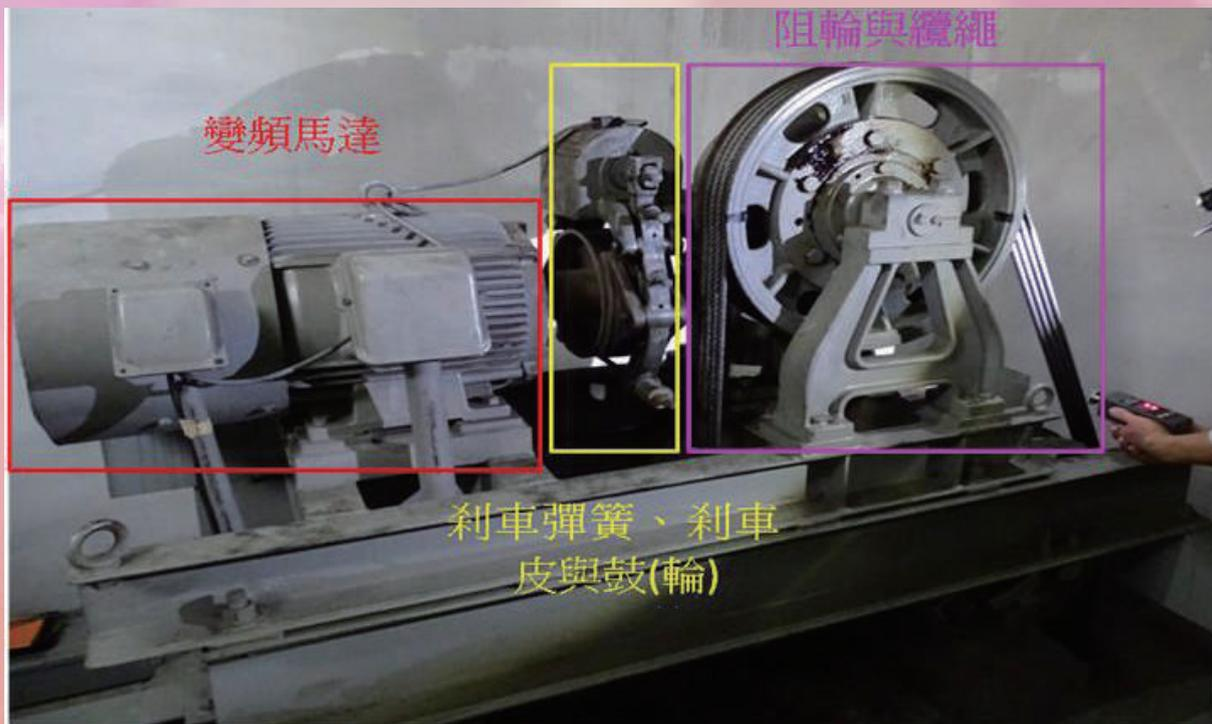
▲ 圖六、電梯煞車系統
